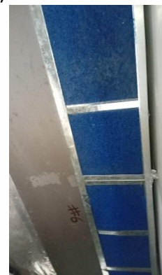
Filtro de Aire de Fan Coil (Después del Mantenimiento)
