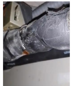
Aislamiento térmico requiere cambio (1" x 3/4" x 3m)
