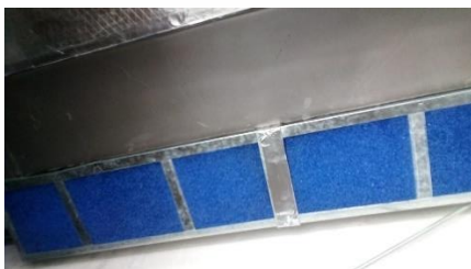
Filtros de aire de Fan Coil (Después del Mantenimiento)
