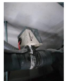
Válvula de doble vía no cierra el pase del agua, requiere cambio 3/4"
