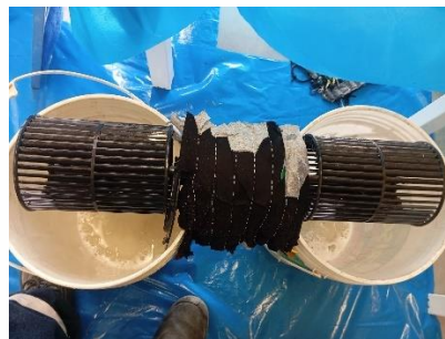
Motor Ventilador de Fan Coil (Antes del Mantenimiento)
