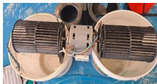
Motor ventilador de Fan Coil (Durante el Mantenimiento)
