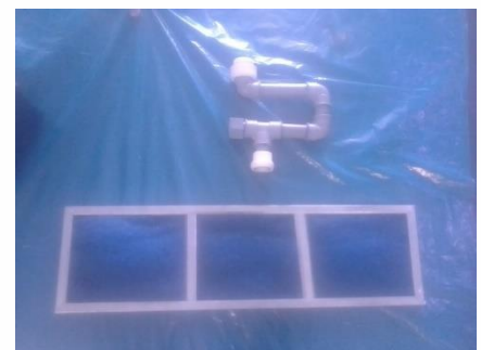
Filtro de aire de Fan Coil (Después del Mantenimiento)
