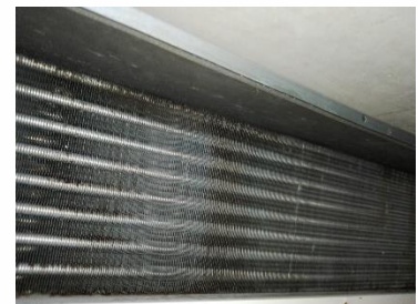
Serpentín de aire de Fan Coil (Antes del Mantenimiento)
