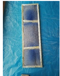
Filtros de aire de Fan Coil (Antes del Mantenimiento)
