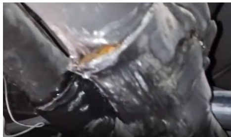
Aislamiento térmico requiere cambio (1" x 3/4" x 3m)
