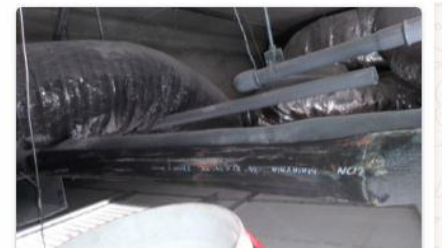
Requiere cambio de manguera aislante 7/8" x 3/4"
