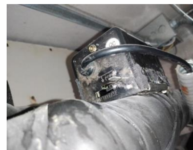
Actuador de válvula de 2 vías no acciona
