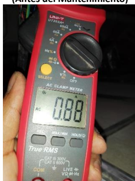
Consumo de corriente de motor ventilador (Después del Mantenimiento)
