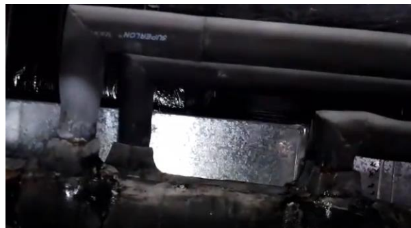
Aislamiento térmico requiere cambio (1 1/8" x 3/4" x 3m)
