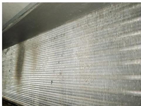
Serpentín de fan coil (Durante el Mantenimiento)
