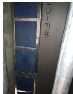
Filtro de Aire de Fan Coil (Después del Mantenimiento)
