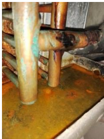
Bandeja de Fan Coil (Antes del Mantenimiento)
