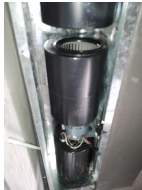
Motores ventiladores antes del mantenimiento
