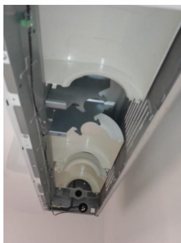
Interior Unidad Evaporadora (Antes del Mantenimiento)
