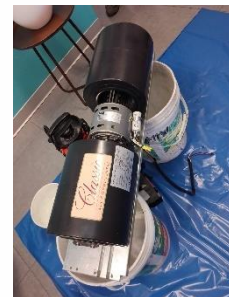
Unidad Fan Coil (Durante el Mantenimiento)
