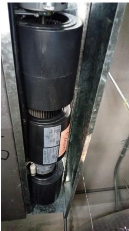
Unidad Fan Coil (Antes del Mantenimiento)
