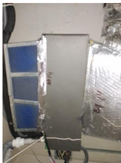
Filtro de Aire Unidad Fan Coil (Antes del Mantenimiento)
