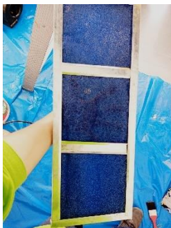
Unidad Fan Coil ((Después del Mantenimiento))
