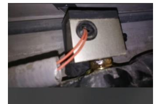
Válvula de doble vía no cierra el pase del agua, requiere cambio.
