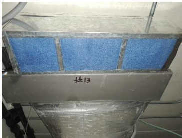
Unidad Fan Coil (Antes del Mantenimiento)
