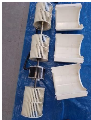
Accesorios Unidad evaporadora (Antes del Mantenimiento)
