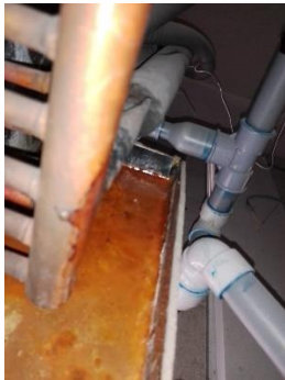
Bandeja Fan Coil (Antes del Mantenimiento)
