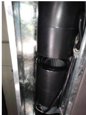
Filtro y motores de aire Unidad Fan Coil (Antes del Mantenimiento)
