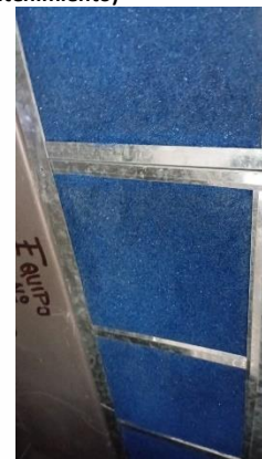
Filtro de aire Unidad Fan Coil (Después del Mantenimiento)
