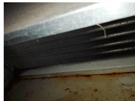
Bandeja unidad Fan Coil (Durante el Mantenimiento)
