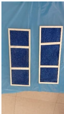
Filtros de aire de unidad fan coil (Después del Mantenimiento)
