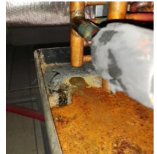
Bandeja de condensado durante el mantenimiento (Durante el mantenimiento)
