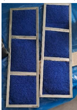
Filtros de aire de Fan Coil (Después del Mantenimiento)
