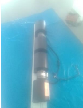
Motor ventilador Unidad Fan Coil (Antes del Mantenimiento)
