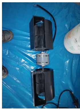
Motor Ventilador de Fan Coil (Antes del Mantenimiento)
