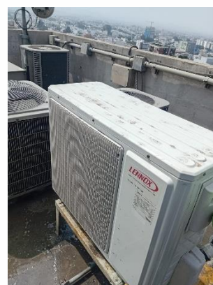
Unidad Condensadora (Después del Mantenimiento)
